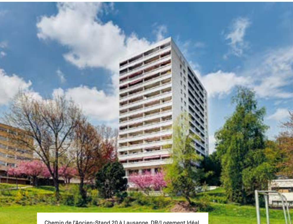
Chemin de l'Ancien-Stand 20 à Lausanne. DR/Logement Idéal
