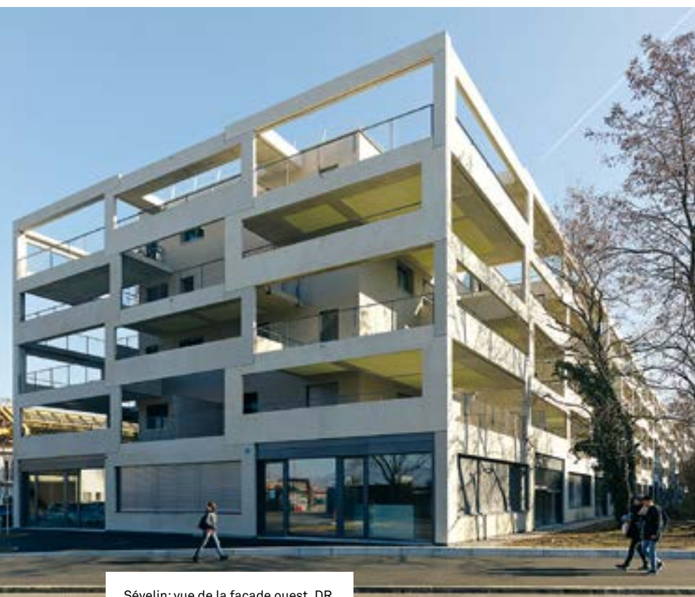
Sévelin: vue de la façade ouest. DR
